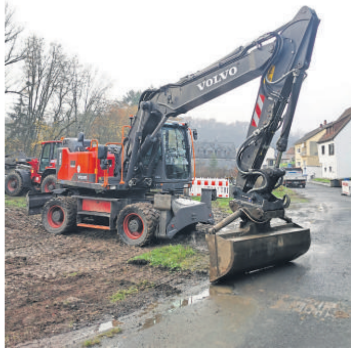
Noch vor Weihnachten werden die Bauarbeiten in Ahausen abgeschlossen sein. Foto: Stadt Weilburg
