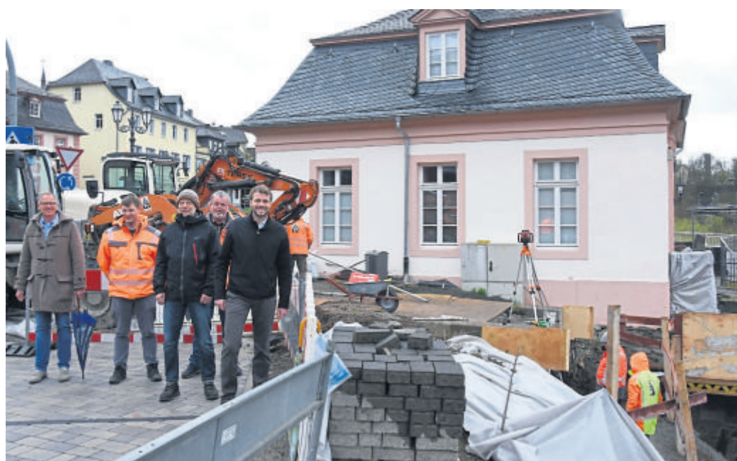
Am Brückenhäuschen wird derzeit der L-förmige Fußweg errichtet. Es machen sich ein Bild vor Ort: (v.l.) Joachim Kinedt, Alexander Erbe, Roger Schmidt, Diethelm Heider und Dr. Johannes Hanisch. Foto: Margit Bach
