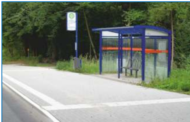
Behindertengerechte Bushaltestelle am Kreiskrankenhaus Weilburg.
