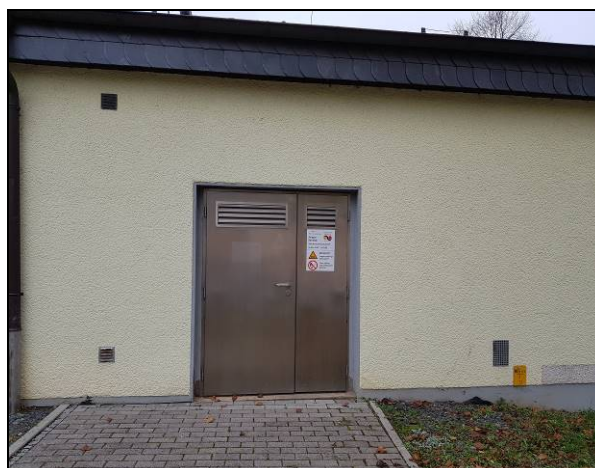
Abb. 9: Versorgungshäuschen im Osten des Plangebiets.
