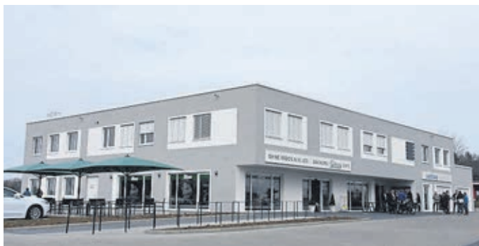
Ein Blick auf das neue Medzentrum in der Frankfurter Straße 69.
