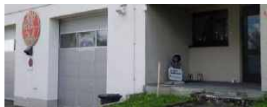
Abb.67: Bürgerhaus Hasselbach, vorh. Radabstellanlage
