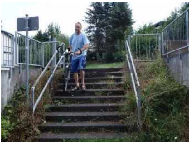
Abbildung 115: Einbau einer Schiebe-Rinne ist erforderlich
