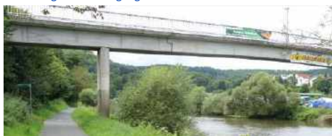
Abbildung 36: Brücke über die Lahn zwischen Odersbach und Kirschhofen
