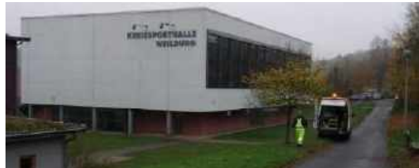
Abbildung 10: Kreissporthalle Weilburg, Foto: VAR+
