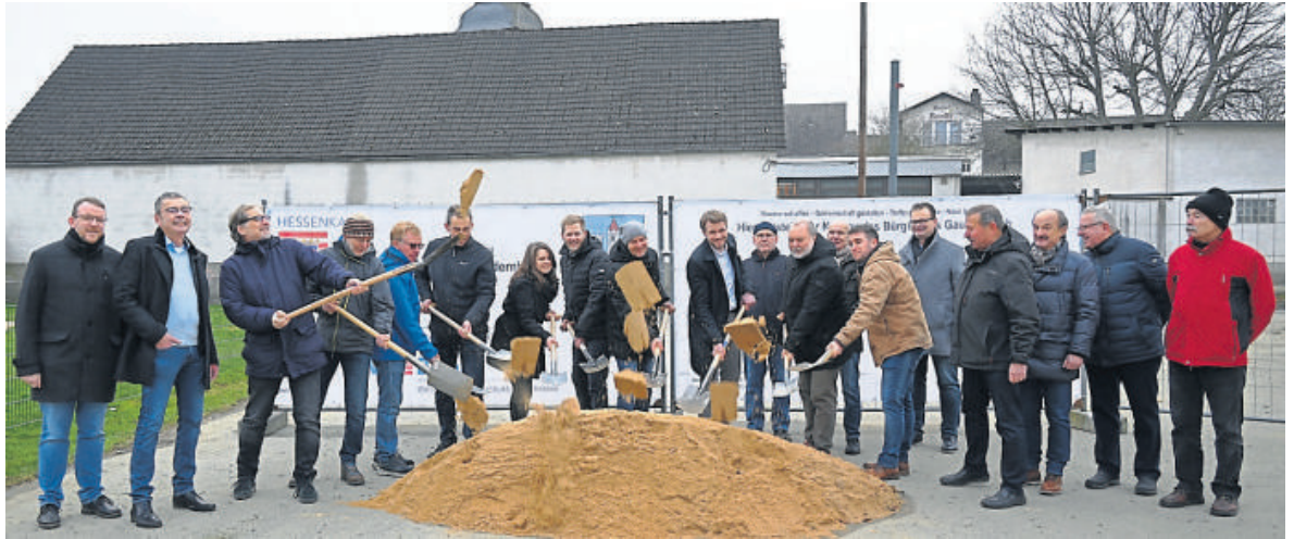
Mit dem Spatenstich läuten die Beteiligten den Start der Bauarbeiten ein.
