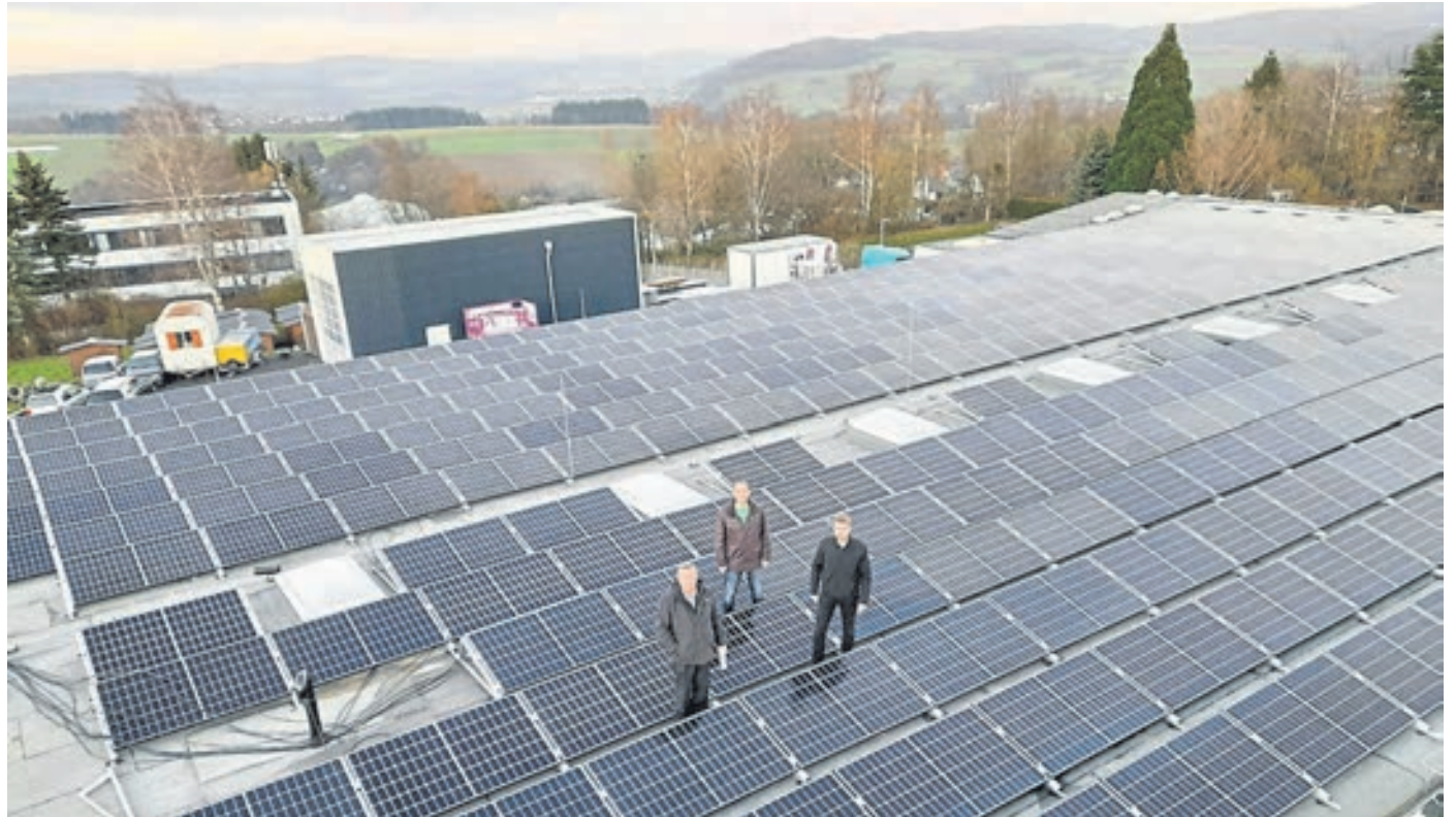
Blick aus dem Korb der Feuerwehrdrehleiter: Bürgermeister Dr. Johannes Hanisch, Wehrführer Christian Gros und der Erste Stadtrat Heinz Schweitzer (von rechts) zwischen 300 Photovoltaikmodulen.
